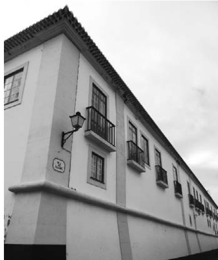
Palácio dos Remédios (fachada poente), Angra
